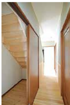
↑箱型階段の下に収納スペースを設けた施工例。
