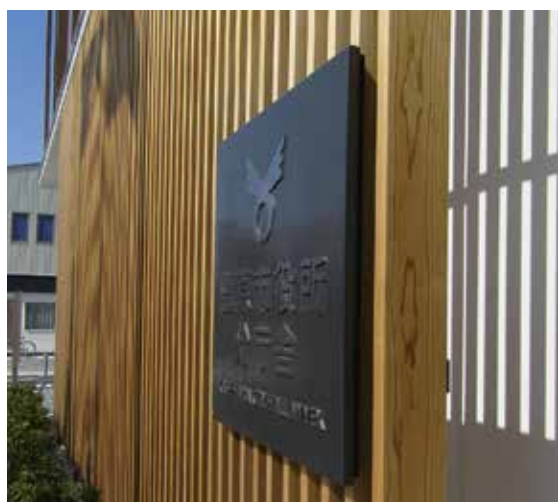
■1階 ルーバー サーモウッド P.94 参照 サーモ処理を施した木材は腐りにくく、外部使用に最適です！
