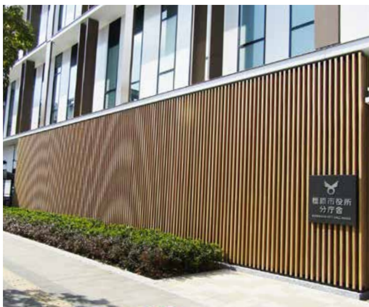
■1階 ルーバー サーモウッド P.94 参照 サーモ処理を施した木材は腐りにくく、外部使用に最適です！
